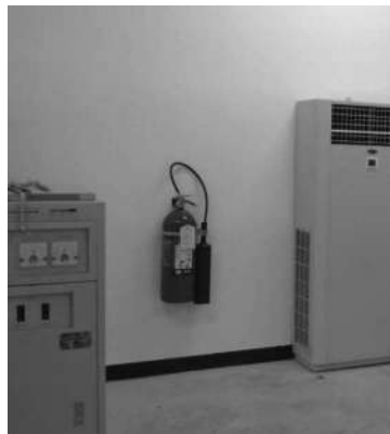
▲ ถังดับเพลิงมือถือชนิดก๊าซคาร์บอนไดออกไซด์เหลว สำหรับใช้ดับเพลิงที่เกิดจากไฟฟ้า ติดตั้งตามอาคารต่างๆ จำนวน 8 ถัง
