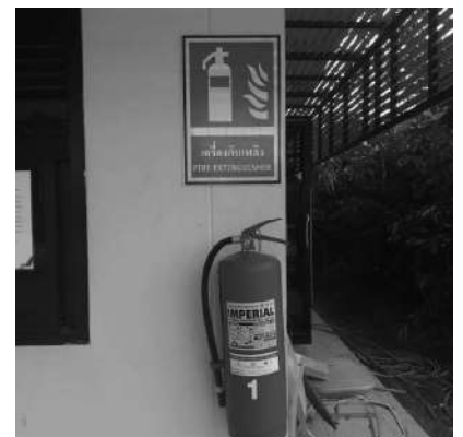
▲ ถังดับเพลิงมือถือชนิดผงเคมีแห้ง 10A40B สำหรับใช้ดับเพลิงทั่วไป จำนวน 36 ถัง
