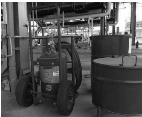
▲ ถังดับเพลิงชนิดผงเคมีแห้ง แบบรถเข็นมีขนาด 150 ปอนด์ ติดตั้งไว้บริเวณโรงจ่ายน้ำมันและบริเวณท่าเรือ จำนวน 2 ชุด
